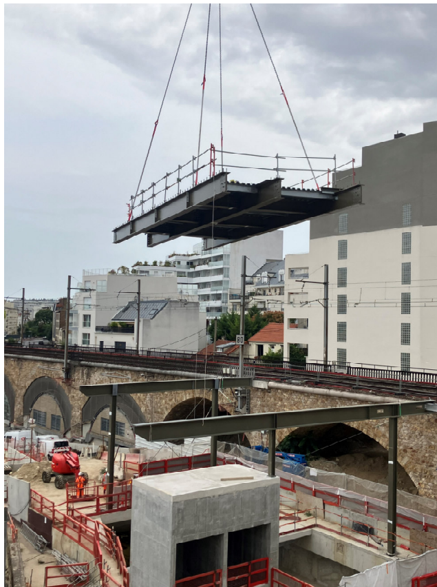
Côté quai B
