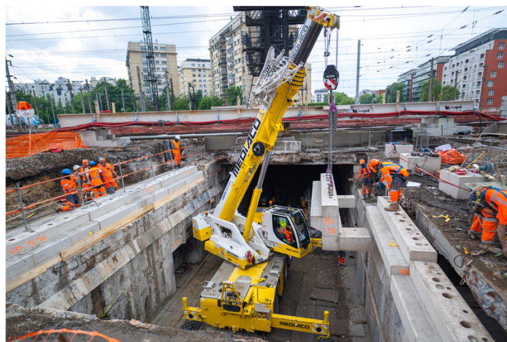
Pose des sommiers à l'aide d'une grue routière depuis le RER C
